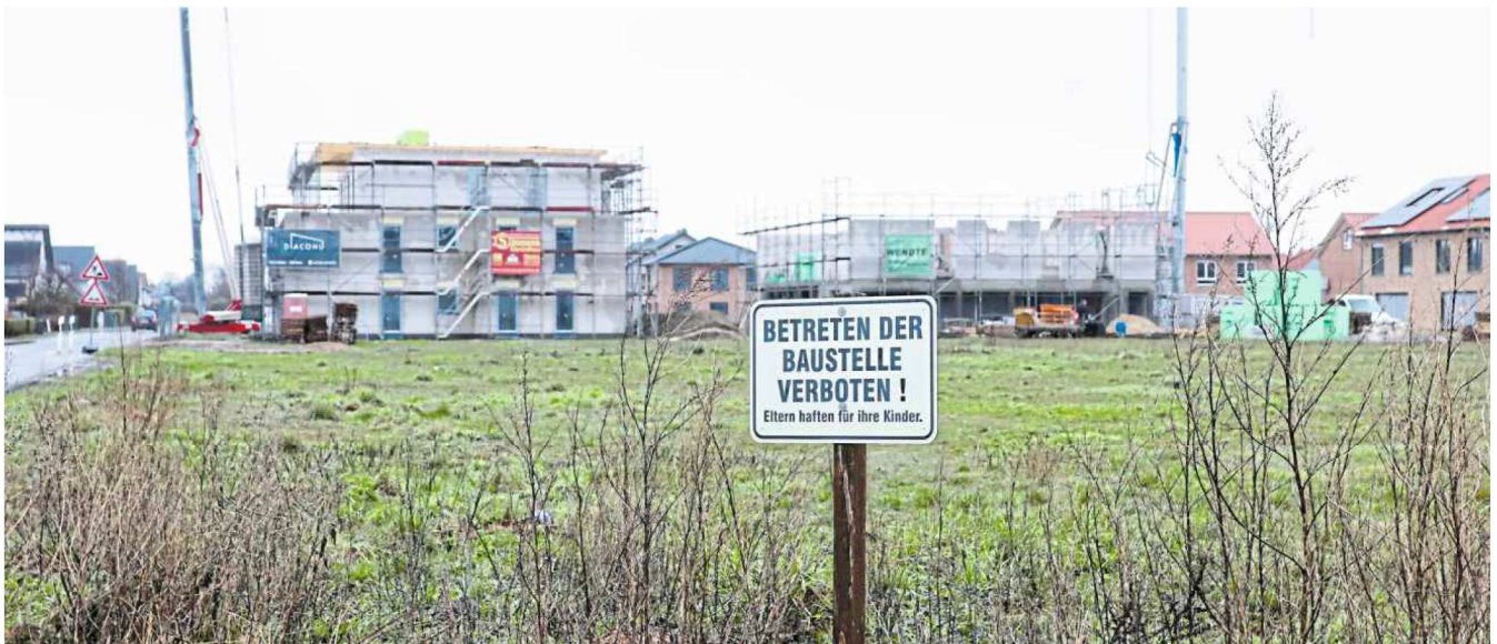
Im Wohngebiet an der Roßbachstraße in Minden werden neue Häuser errichtet.
